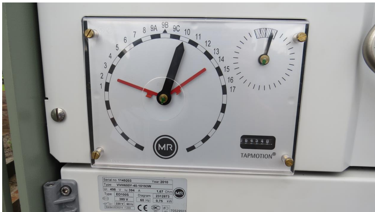
Modelo do comutador de TAPS existente no transformador atual.
