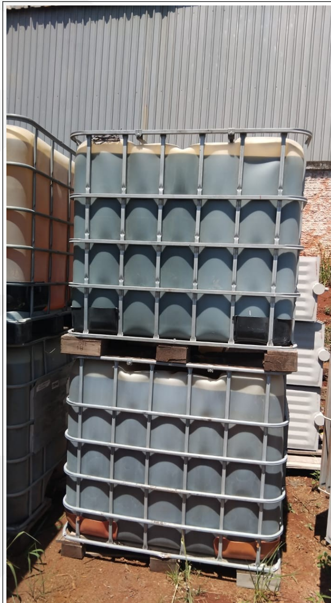
Foto 18 – Óleo do transformador com contaminante PCB
